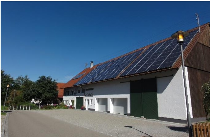
Abbildung 37: Umgebaute ehemalige Hofstelle an der Vöhlinstraße
