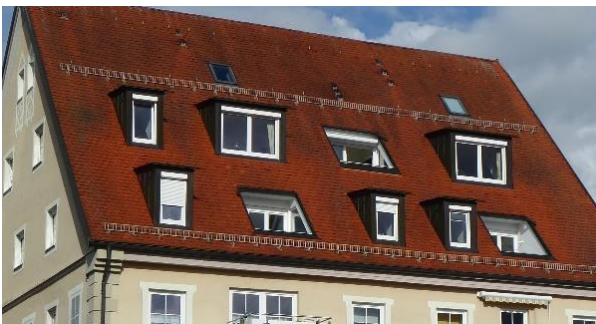
Abbildung 64: Schleppgauben in Kombination mit Dacheinschnitten (nicht zulässig)
