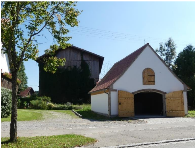
Abbildung 35: Gebäude für Postkutsche / Pferde
